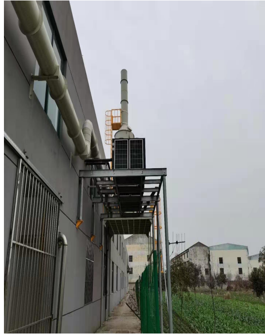
排气筒和生物除臭装置
